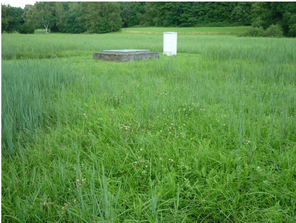
Abb. 1: Nibelungenquelle als Beispiel eines Tiefbrunnens
