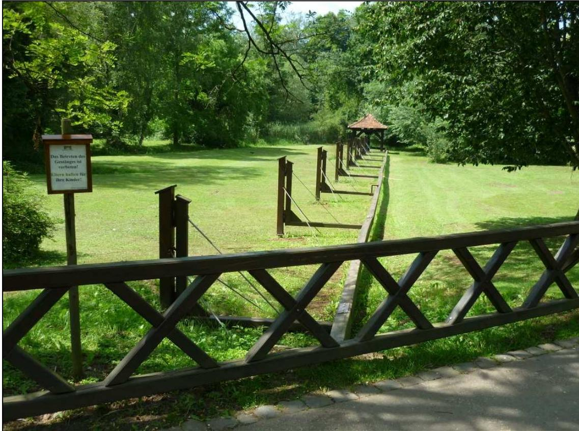
**Abb. 7: Stangenkunst zwischen Wasserrad und Pumpenhäuschen. Die einzelnen Teile der Anlage befinden sich noch an ihren ursprünglichen Orten, wenn auch große Teile inzwischen erneuert werden mussten.**
